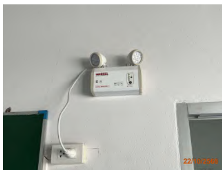
ภาพที่ 2.2-31 ระบบไฟฟ้าสำรองส่องสว่างและไฟฉุกเฉิน (Emergency Light)
